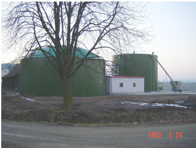
Abb. 1: Gesamtüberblick Biogasanlage OBERNJESA
