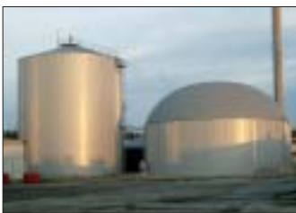
Diese Anlage steht auf dem Gelände einer Tierzuchtanlage in Sandbeiendorf.
