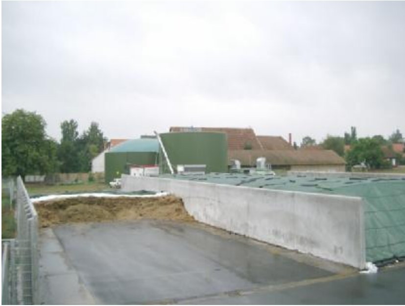
Bild 1: Gesamtüberblick Biogasanlage OBERNJESA
