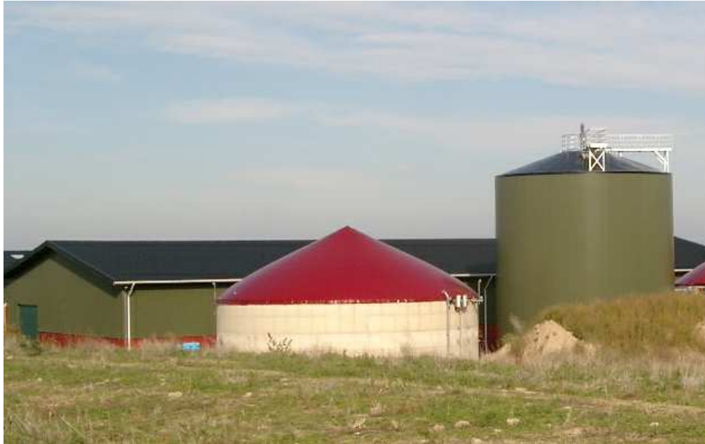
Abb. 6: Fermenter und Nachgärung Biogasanlage SCHORNBUSCH
