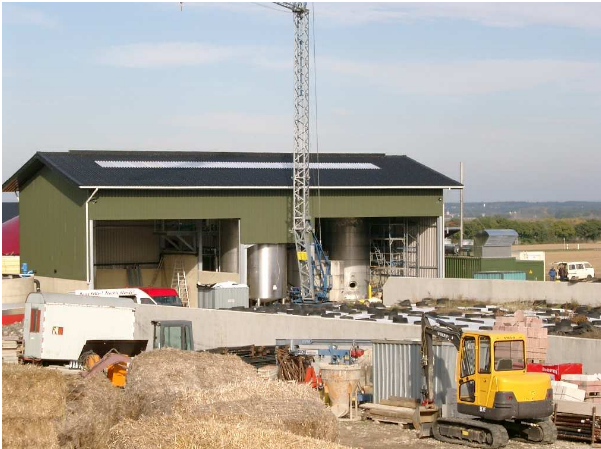
Abb. 7: Blick in die Gerätehalle Biogasanlage SCHORNBUSCH während der Bauphase. Rechts Silageplatte
