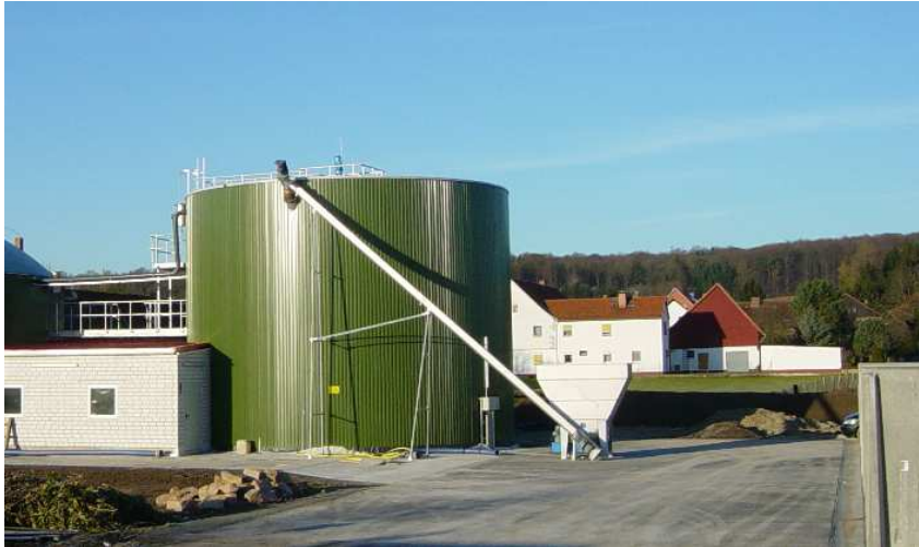
Abb. 4: Feststoffeintragstechnik in den Fermenter OBERNJESA
